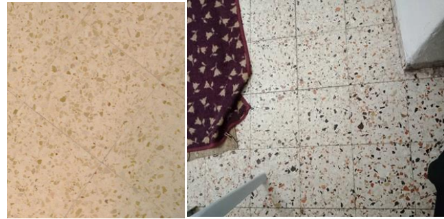
شكل 6 نماذج لبلاط بلدي بزرة مأخوذة من مساكن البلدة القديمة المصدر الباحثة 2020
